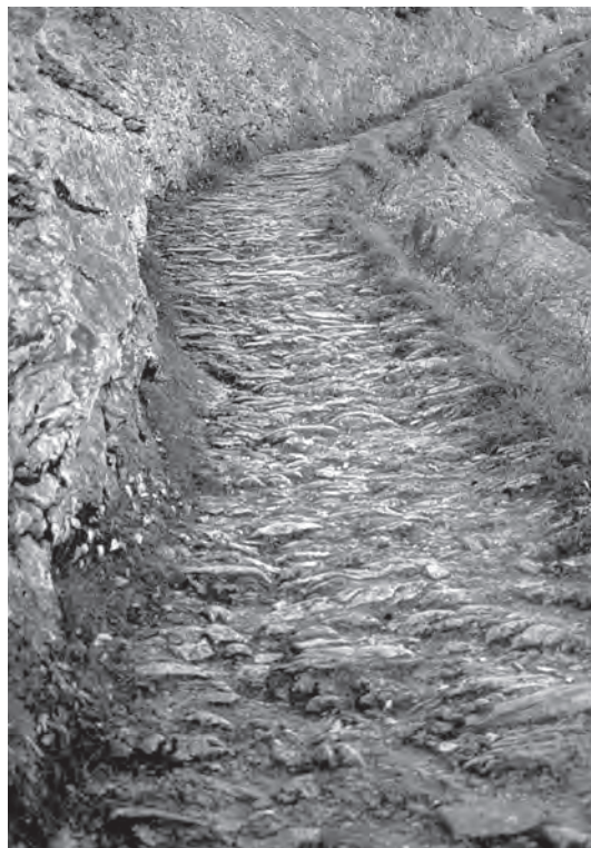
Abb. 5 (links): Die Mettlengasse in Attinghausen (UR), erbaut 1899–1901, ist Teil des Surenenwegs. Die seitlichen Mauern hindern das Vieh am Ausscheren auf die benachbarten Weiden. (Foto Andres Loepfe)
