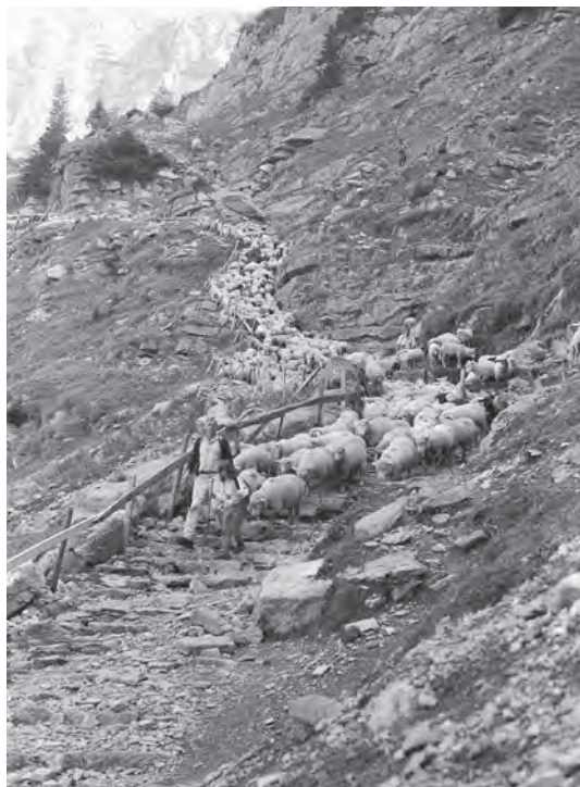
Abb. 7: Der Weg vom Bisistal auf die Glattalp (SZ) weist typische Elemente eines Alpwwegs in steilem Gelände auf: Treppenstufen und ein talseitiges Geländer. (Foto Christine Doerfel)
